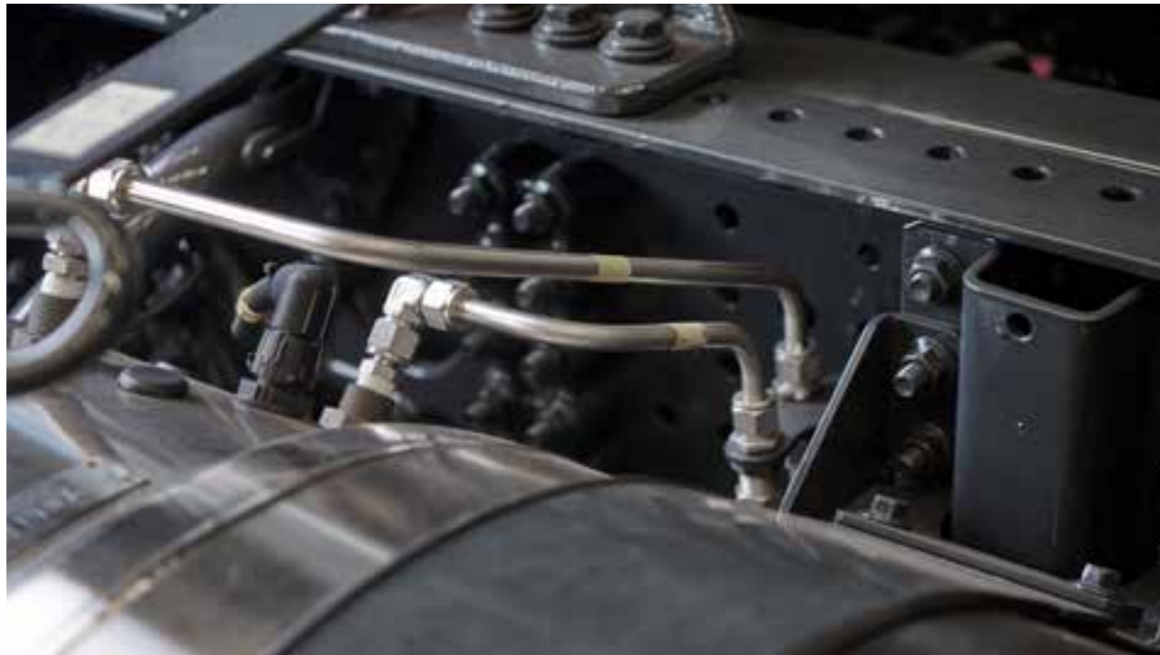
Der LNG-Tank muss in ordnungsgemäßem Zustand zurückgegeben werden, wie auf dem Bild dargestellt.
